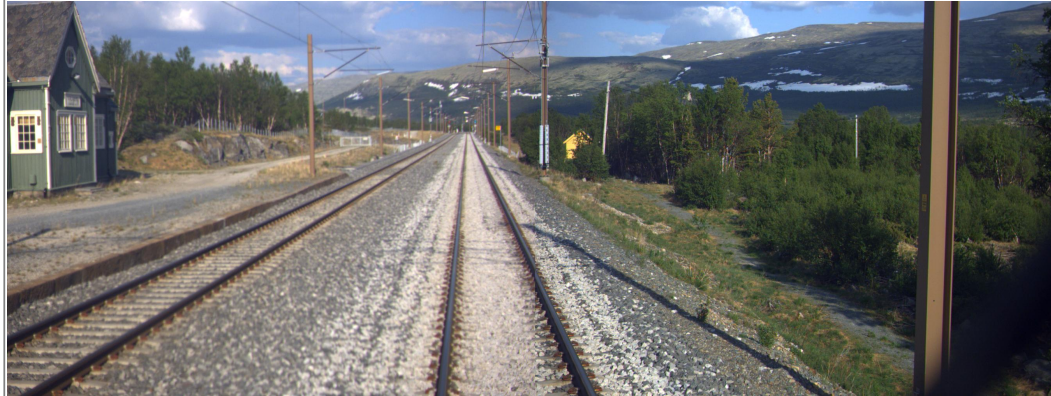
Vålåsjø stasjon, Bane NOR Eiendom
